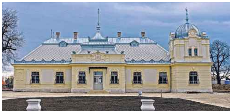
A felújítás után újra eredeti pompájában látható a gyönyörű épület
